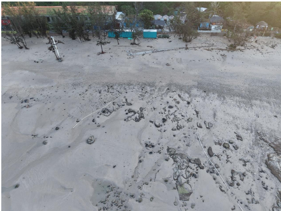
沙滩退化导致海底管道裸露断裂（无人机拍摄影像）
