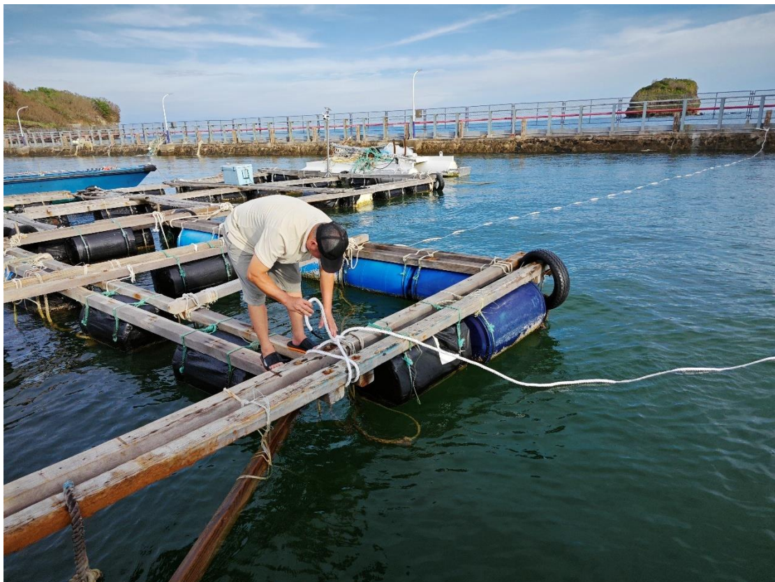
工作人员正在加固海上浮排
