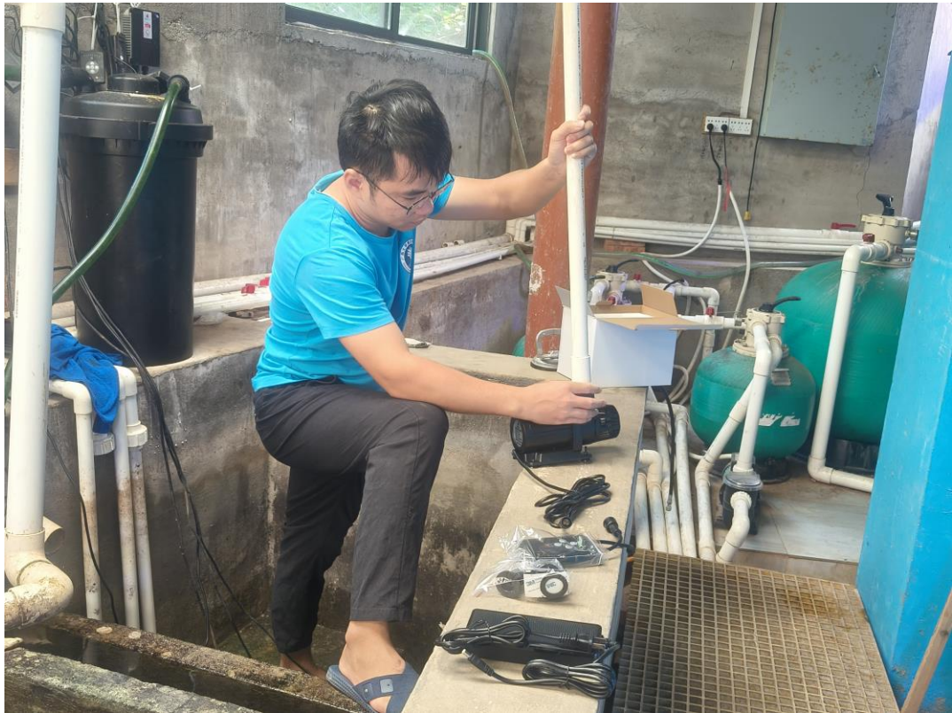
工作人员在更换十米缸循环水泵
