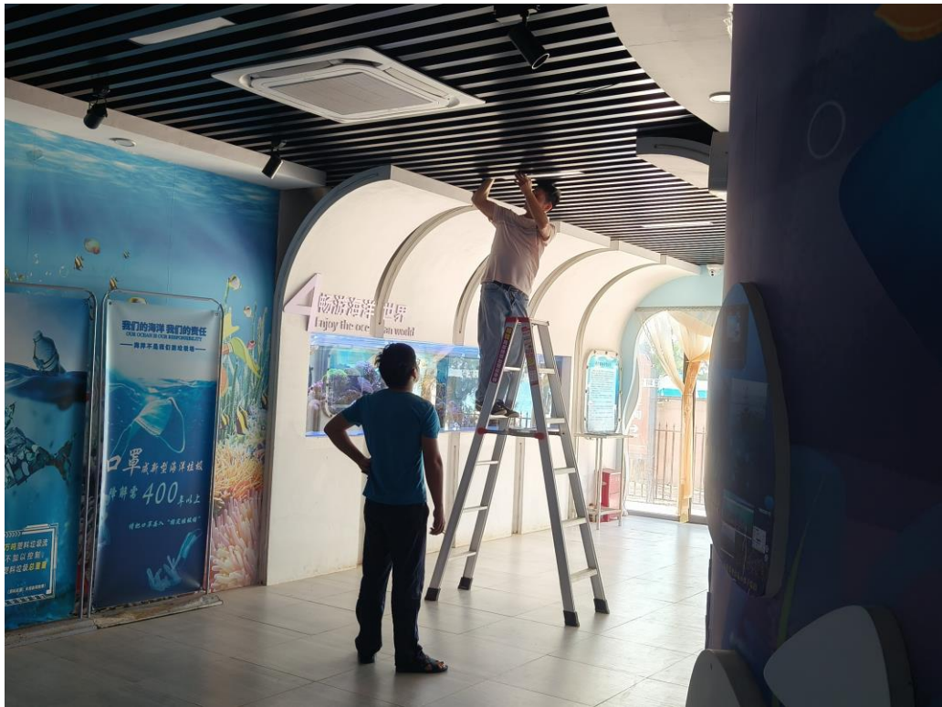
工作人员在更换展厅 LED 灯
