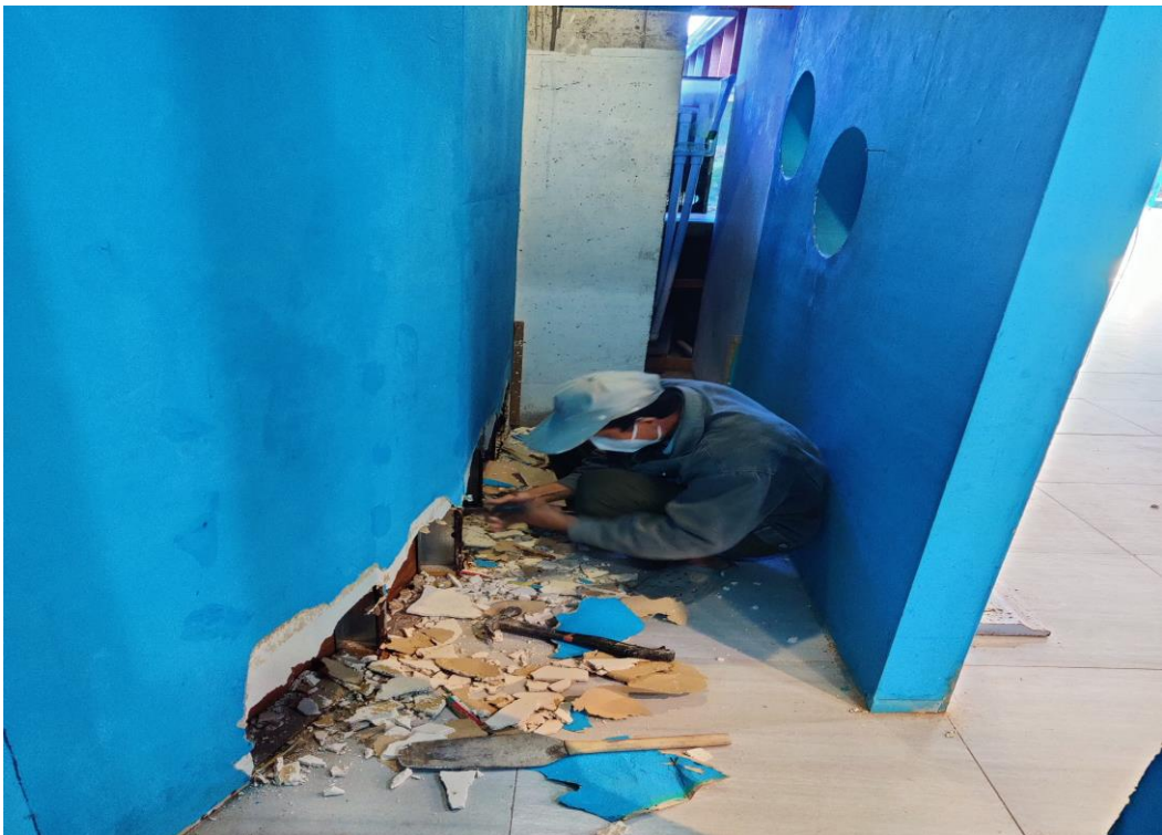
工人在更换修补腐蚀的墙皮
