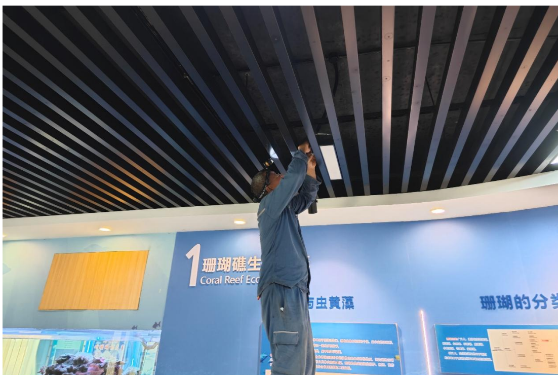
正在更换展厅内损坏的照明灯
