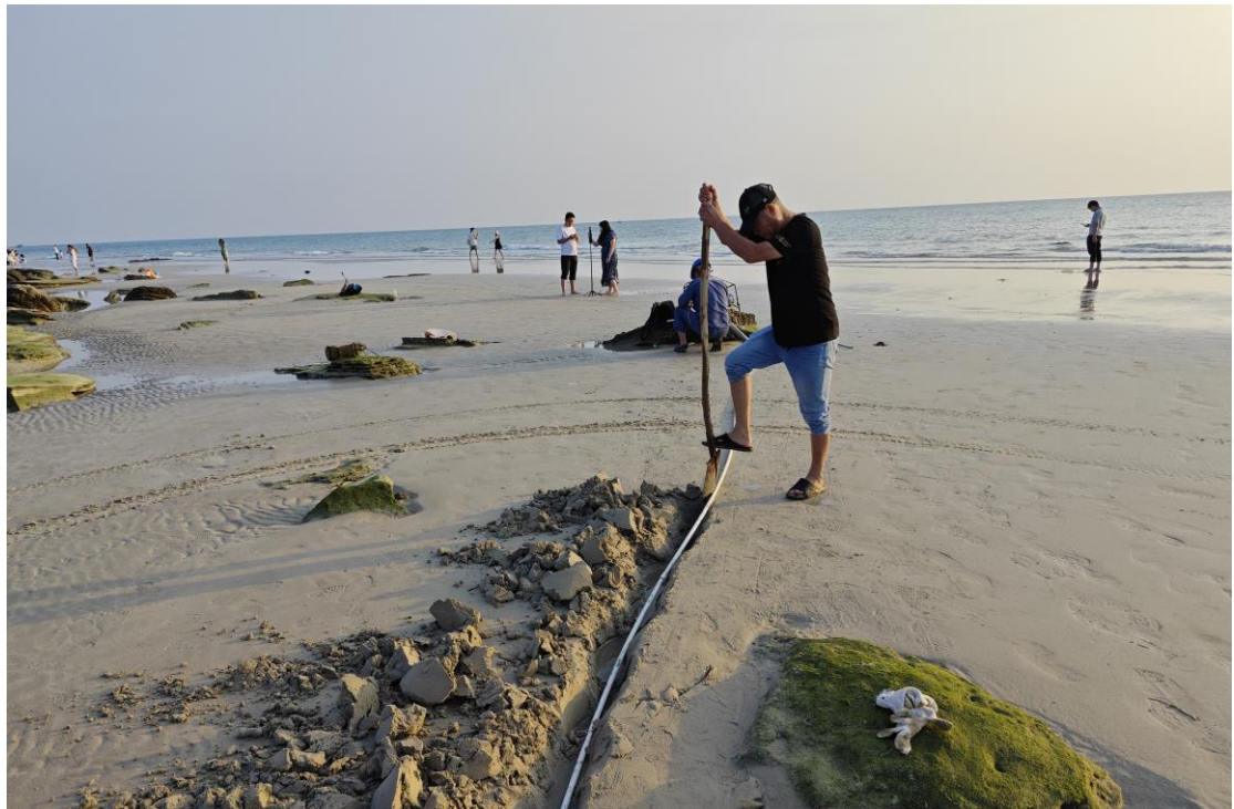
工作人员正在重新填埋海底电缆和更换海底水泵
