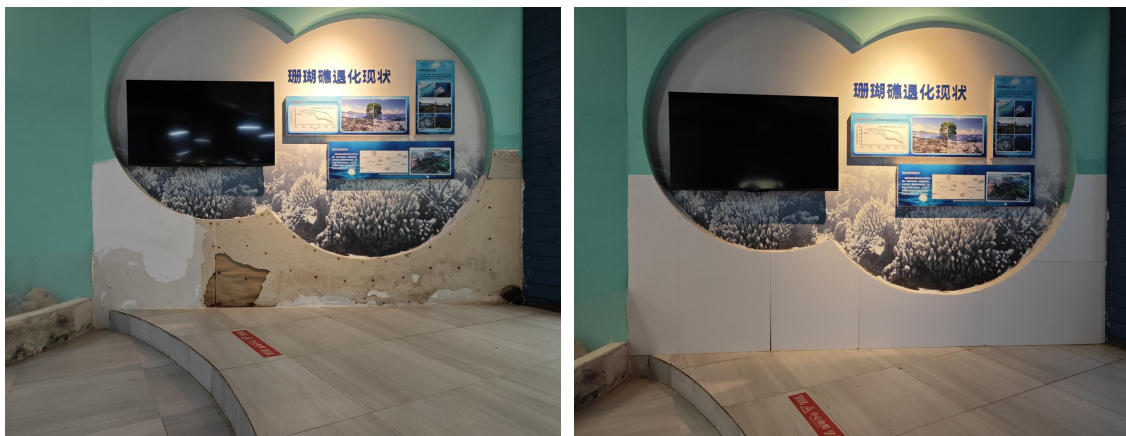
破损墙面基础修复前后对比
