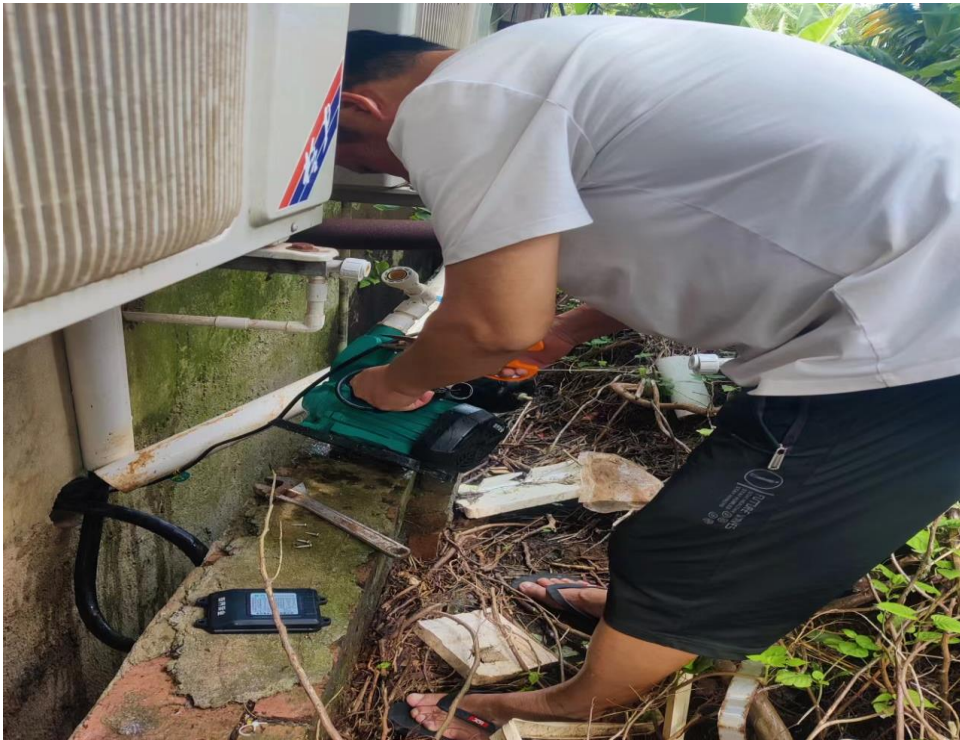
工作人员在更换增压泵传感器
