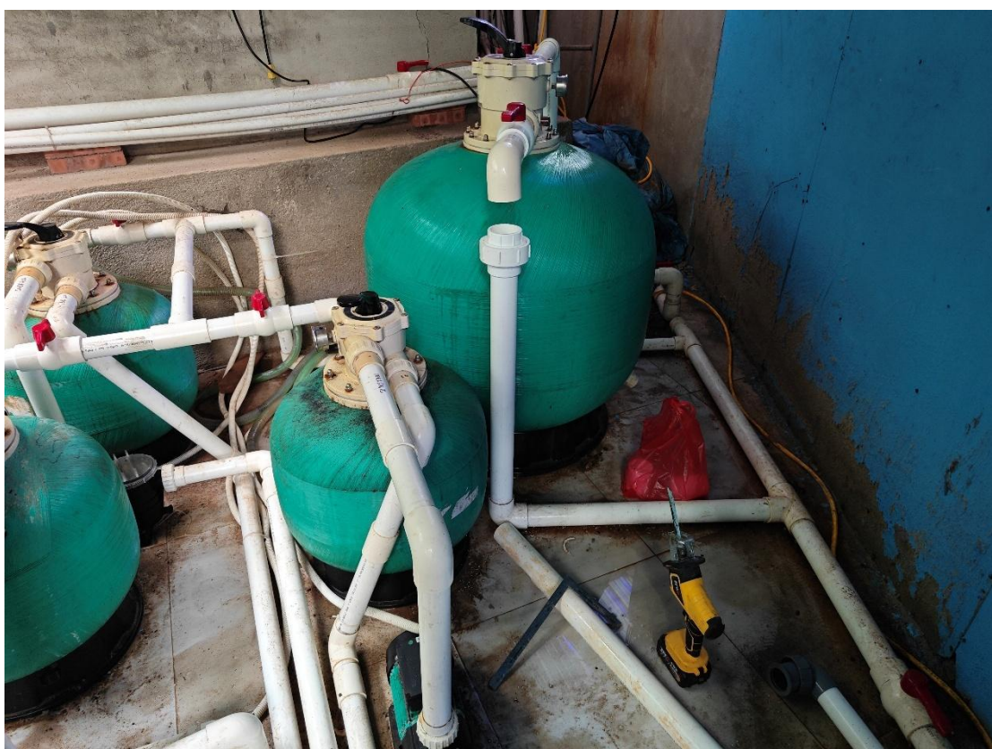
工作人员正在更换砂缸球阀
